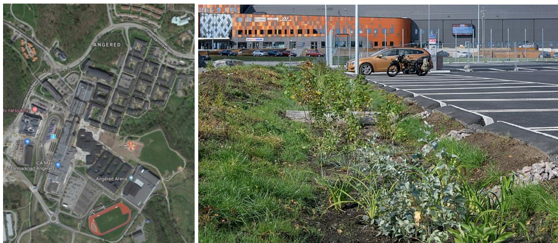
Figur 6 Bilden till höger visar Angered centrum som är ett exempel på en medelbelastad yta. Till höger visas en bild på regnrabatten vid Kvibergs arena som är ett exempel på lämplig dagvattenrening i detta typ av område.
