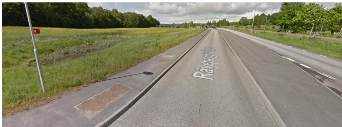
Figur 7 Bilden visar Rävebergsvägen som är ett exempel på en hårt belastad yta. Till vänster i bilden syns en damm längs med vägen, byggd för att rena dagvatten. Dammen hanterar idag inte dagvattnet från vägen men denna typ av lösningar uppfyller kravet på rening för hårt belastade ytor.
