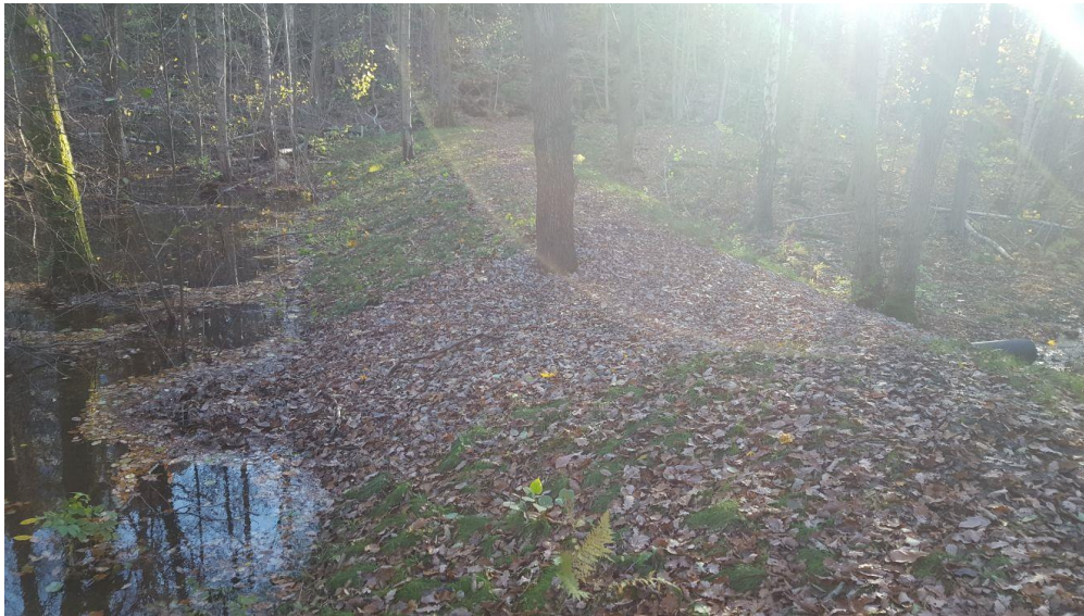
Figur 25 Enkla lösningar som att skapa en jord och makadamvall kan hindra nedströms bebyggelse från skyfall. Foto från Guldheden av Linnea Lundberg
