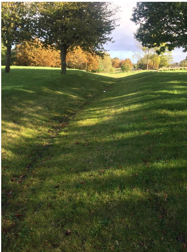
Figur 26 Diken är robusta lösningar som kan användas både för rening och fördröjning av dagvatten och vid skyfall med rätt utformning. Diken bidrar dessutom till en grönare miljö.
