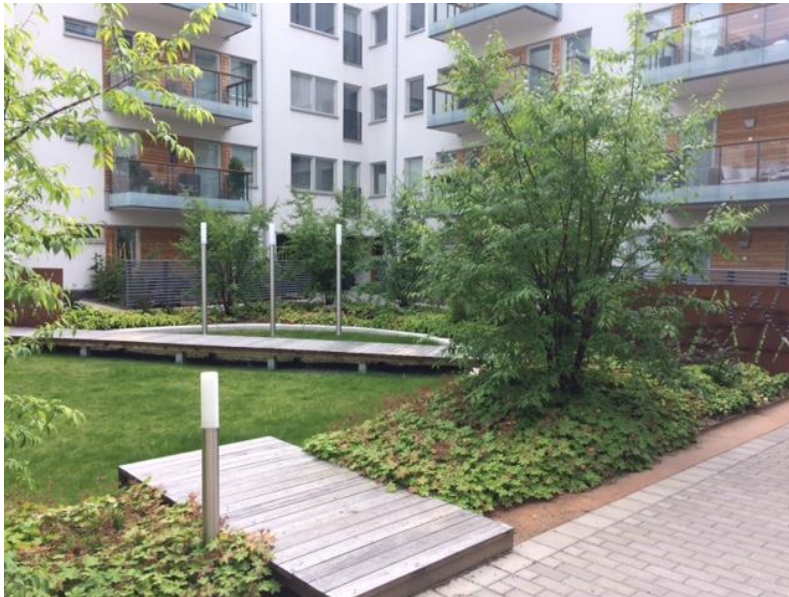
Figur 23 Gröna ytor i bostadsmiljöer kan bidra till en bra dagvattenhantering, bara de utformas rätt. Notera att grönytan ligger något lägre än omgivande vägar och hus. Foto Helena Frohm.
